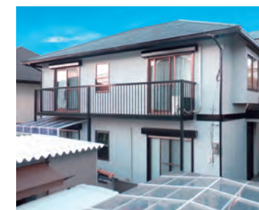
施工から5年経過後の様子
