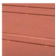
施工直後のUP
