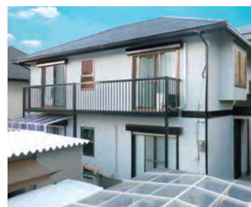
施工直後の様子
