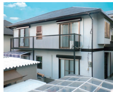
施工直後の様子
