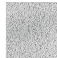
施工直後のUP
