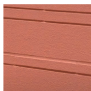
施工直後のUP
