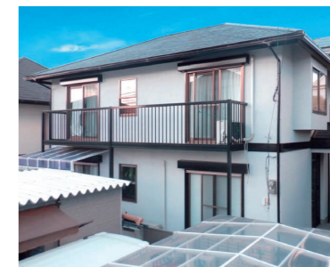
施工から5年経過後の様子
